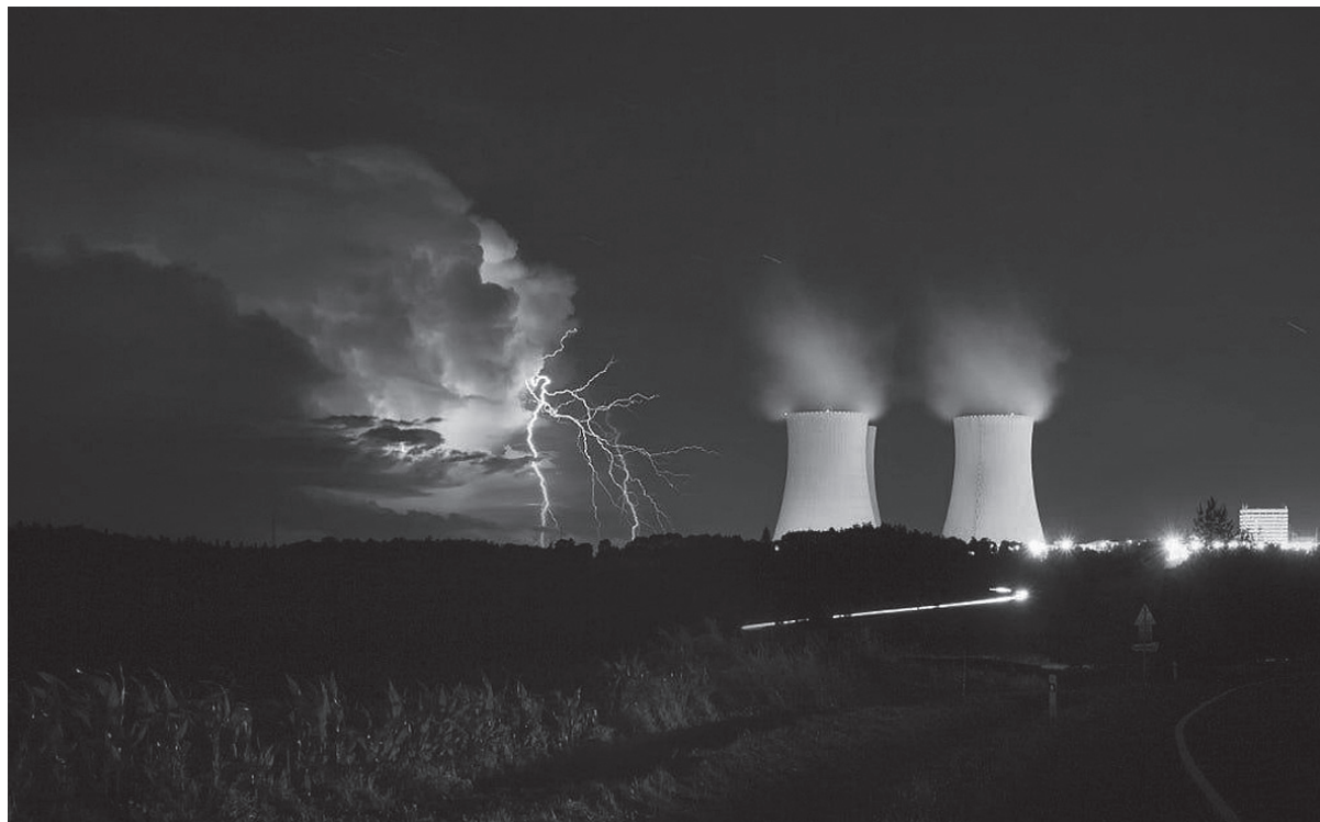
Astravo atominė elektrinė. Nuotrauka iš „Telekon“ (2020 11 22)
